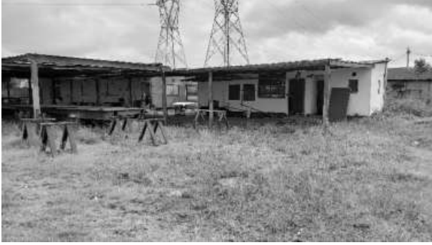
Steel works tenant
